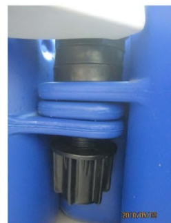
13.6 เมื่อขันยึดสกรู พินสั้น และ อุปกรณ์ผูกเชือกจอดเรือด้านข้าง ที่จุดเจ็ทสกี สำหรับ 1 ลำ จะพร้อมใช้งาน
